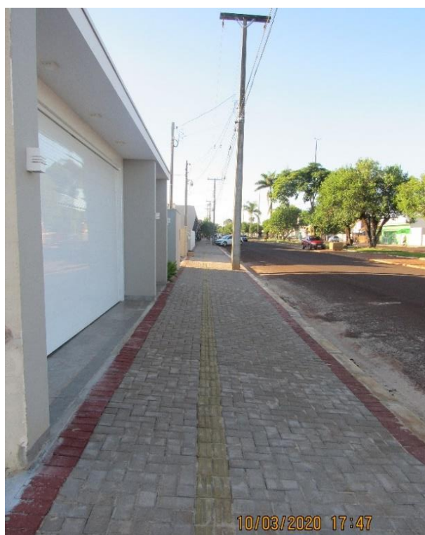
Imagem 1 – Calçamento Inadequado à Arborização Urbana
